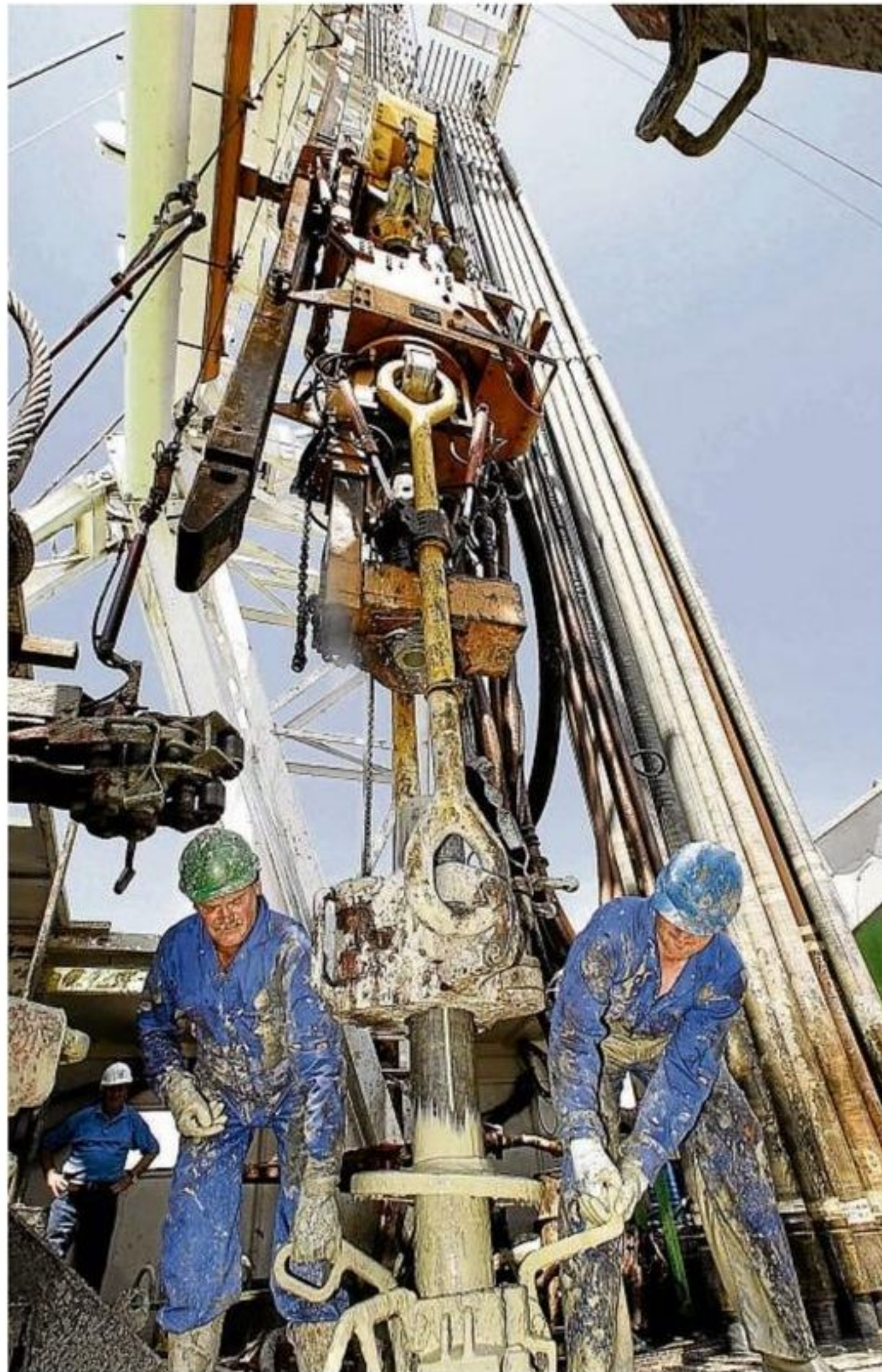
Auf Suche nach Erdwärme: Arbeiter bei der Geothermie-Bohrung in Unterhaching.
